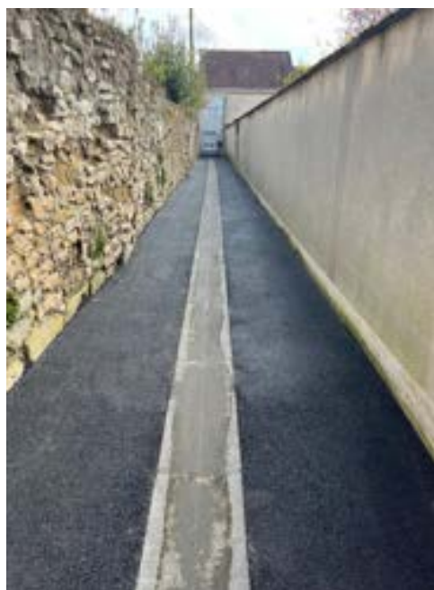
Réhabilitation de la ruelle de l'église
